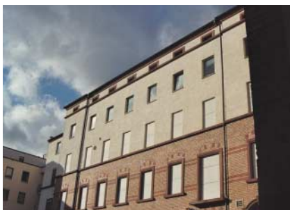
[Abb_3] Innenhof der „Alten Post“ (Agenturräume)
